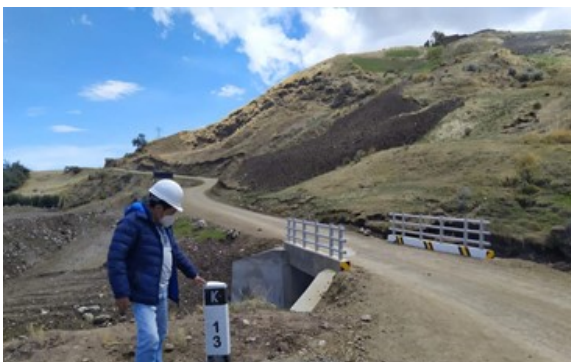
CARRETERA VECINAL CCELLCCOY - LOCROJA - YAURECCAN - OCCOPAMPA DISTRITO DE LOCROJA
