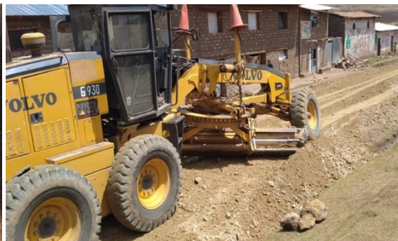
CARRETERA VECINAL - 20.85 KM. EN CHACAPUNCO - ALTO MARAYNIYUCC - PARCO ALTO - CCOCHACCASA
