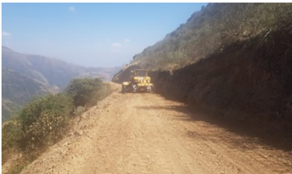
CARRETERA VECINAL - EMP. PE 3SD (LACHOCCASA) - CATAAC - HUARIBAMBA, DISTRITO DE HUARIBAMBA
